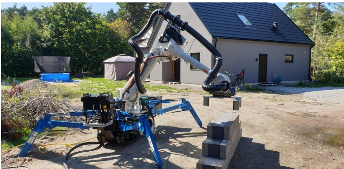
Figur 1 Robotiserat byggsystem – Bettan vid byggnation av vägg med Finja exakt isolerblock. Bildkälla: Mathias Haage, Lunds universitet.
